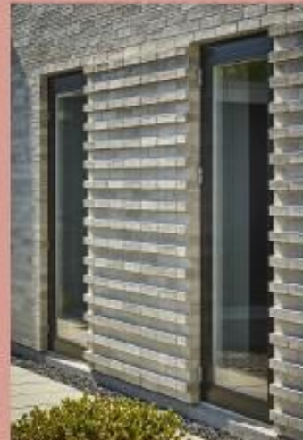
metselwerk begane grond
